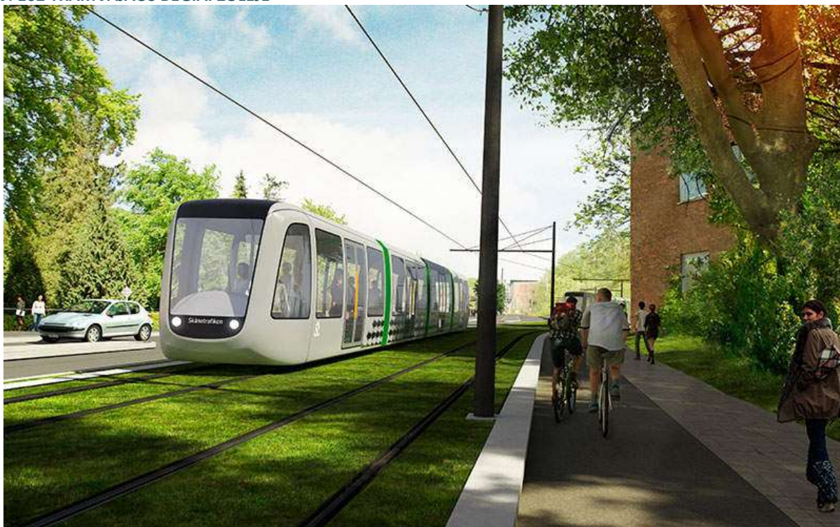
PAV. 102 TRAMVAJAUS BĖGIAI ŽOLĖJE
